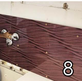
GIỮ KÍNH CỐ ĐỊNH Sau khi lắp kính xong, cần giữ cố định 15 phút cho keo silicon khô lại và dính chặt kính.
