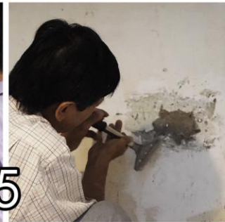
TRÁM VÀ CÀO BẰNG tường sau khi tháo dỡ sẽ có rất nhiều chỗ lõm và lồi. Nhân viên cần xử lý bề mặt thật cẩn thận trước khi lắp đặt kính.
