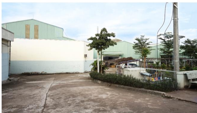
MECHANICAL FACTORY ... XƯỞNG GIA CÔNG CƠ KHÍ ... VIET NAM
